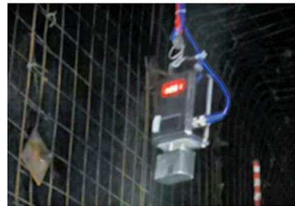
图 6 无动力粉尘浓度传感器现场安装图
